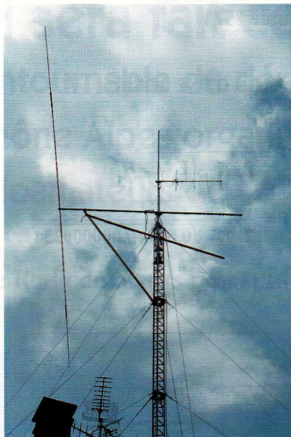
1 - Mise en place de la potence après le montage d'un élément d'extrémité.
